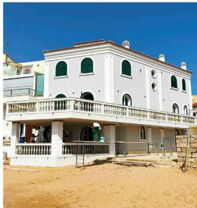
LA CASA DI MONTALBANO (RG): Facciata trattata con Afontermo®
