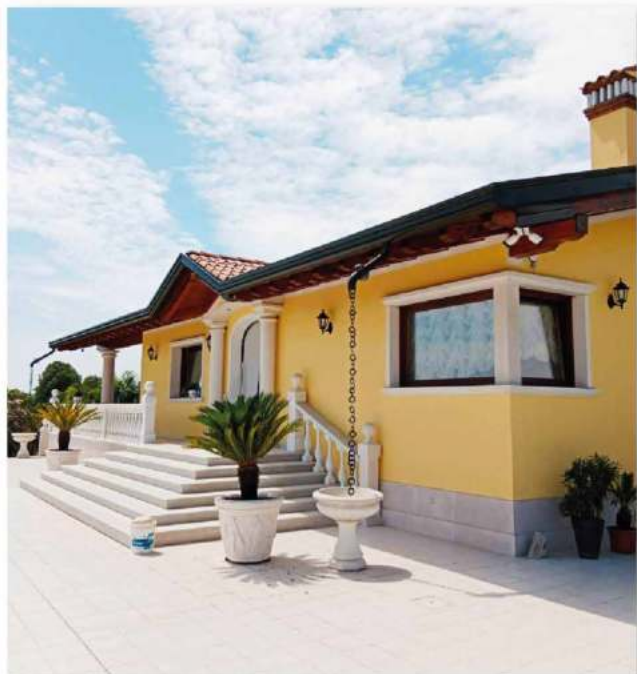
PORDENONE: Facciata trattata con Afontermo®
